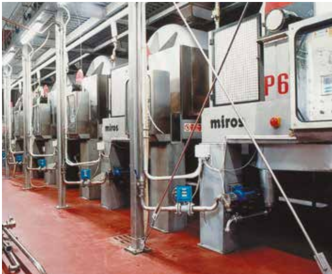
IMPIANTO AUTOMATICO GESTIONE MOSTI
